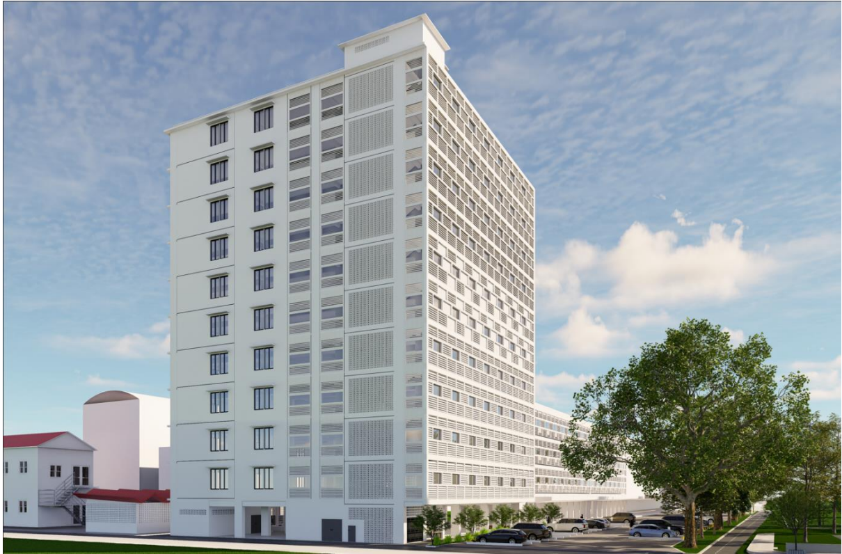
Figure 6: Bâtiment complexe de 11 étages sur le campus principal de l'ITC (2)
