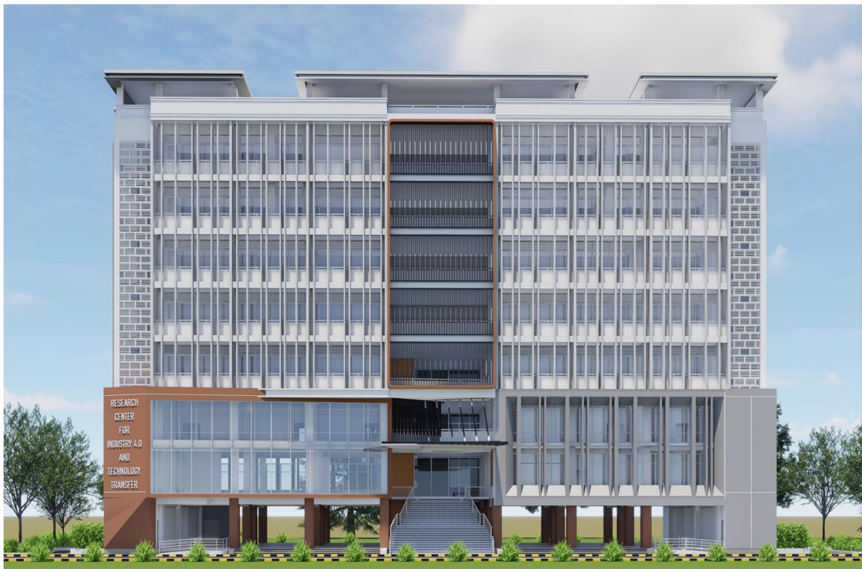
Figure 7: Bâtiment industriel 4.0 de 8 étages (1)
