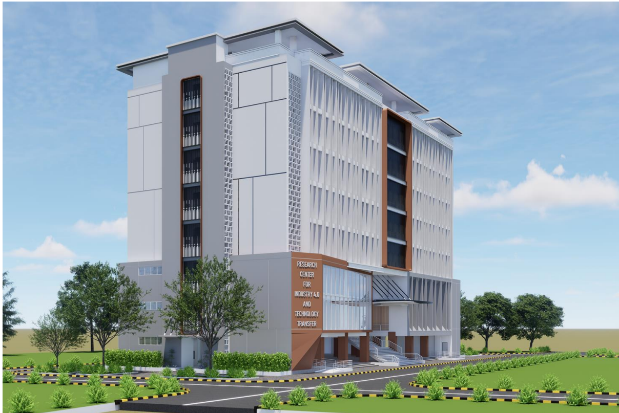
Figure 8: Bâtiment industriel 4.0 de 8 étages (2)
