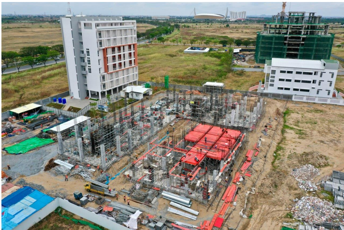
Figure 4: Centre de Recherche et de Transfert de Technologie en construction
