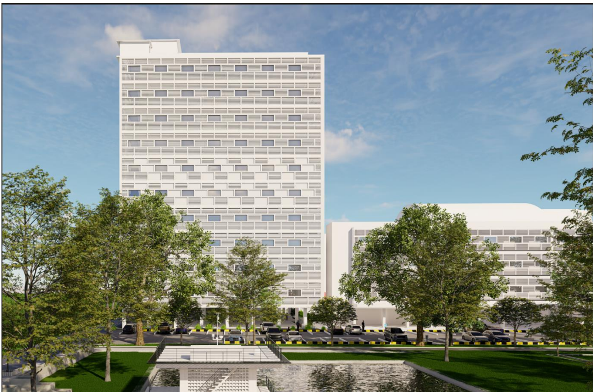
Figure 5: Bâtiment complexe de 11 étages sur le campus principal de l'ITC (1)
