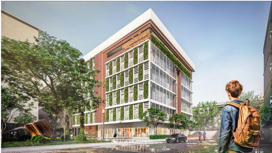
Figure 11: Nouvelle bibliothèque de 6 étages de l'ITC
