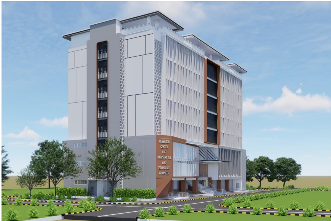
Figure 10: Bâtiment industriel 4.0 de 8 étages (2)
