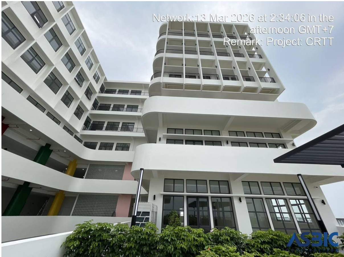
Figure 6: Centre de Recherche et de Transfert de Technologie en construction
