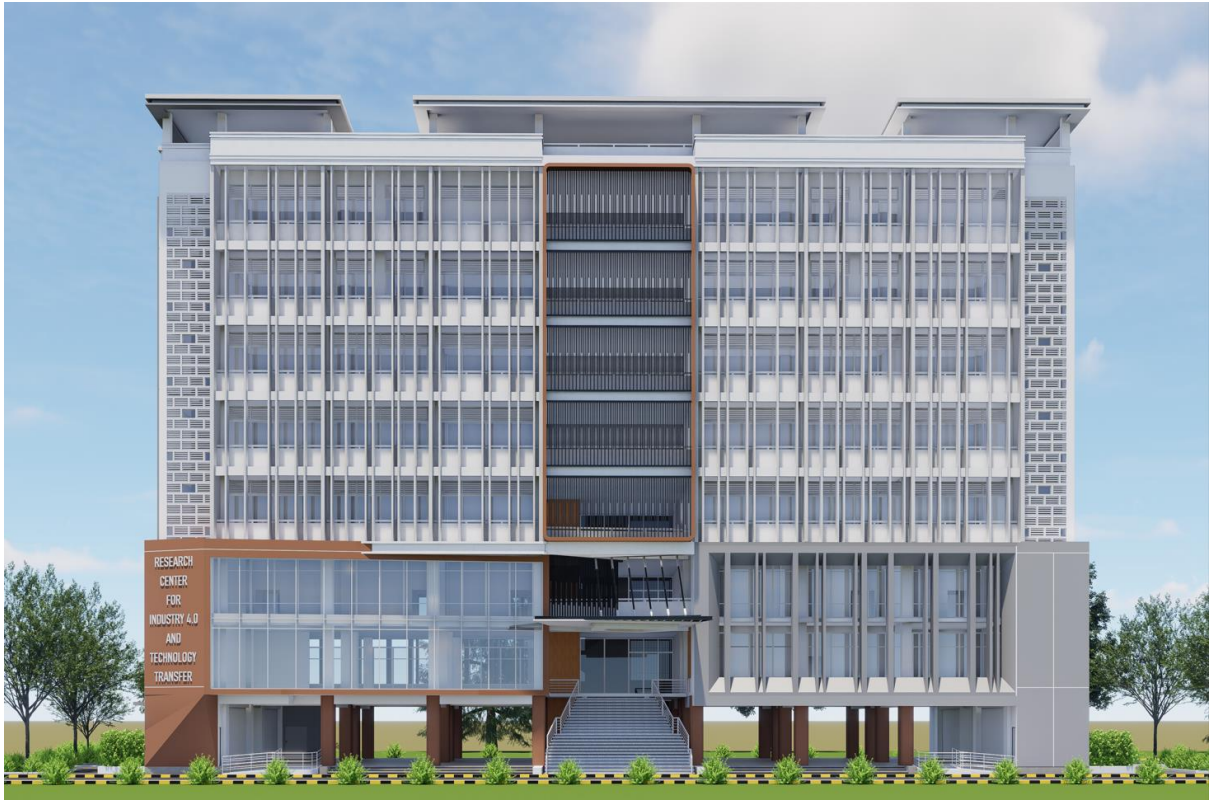
Figure 9: Bâtiment industriel 4.0 de 8 étages (1)
